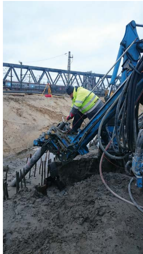
Bild 10 Bohrlochvermessung Drill hole measurement
