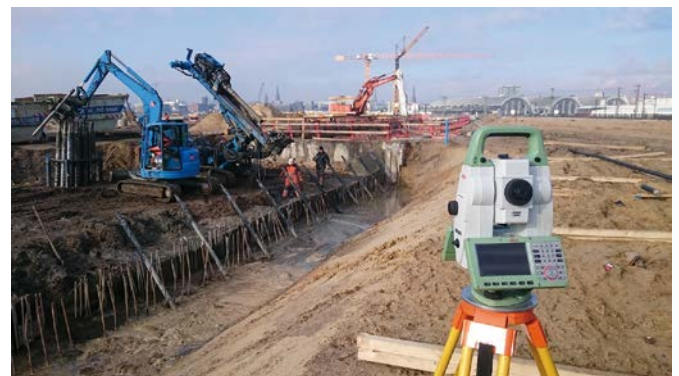
Bild 8 Einrichten der Bohrlafette Drilling-setup
