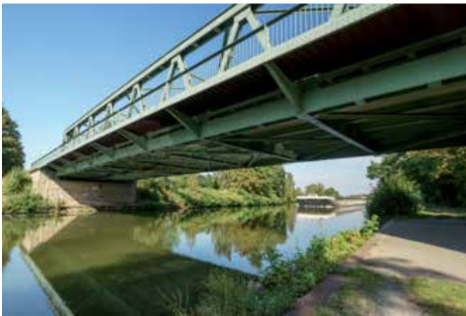
Bild 12 Brücke Nr. 489 Bridge No. 489
