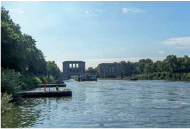
Bild 2 Unterer Vorhafen der Schleuse Üfingen Lower exit basin of the lock Üfingen
