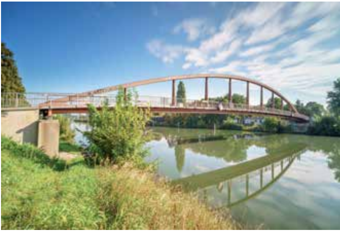
Bild 13 Brücke Nr. 491 Bridge No. 491
